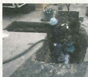
水道管布設工事
