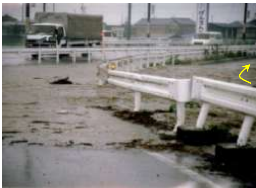
県道 15 号久居美杉線は浸水の危険性が高い状況
