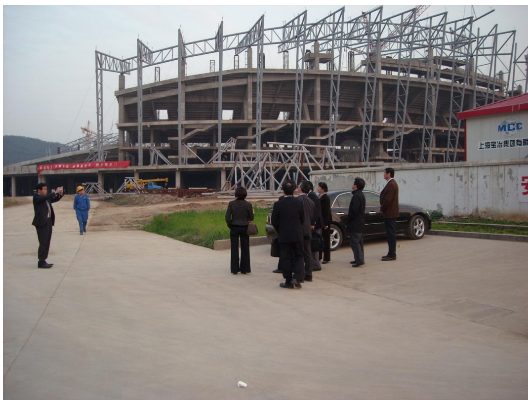
建設現場の視察
