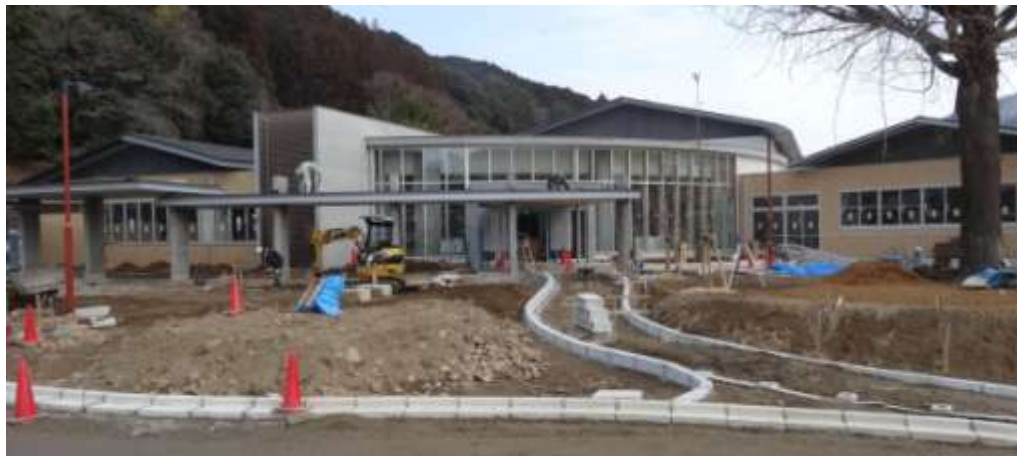
工事中の総合文化センター(2月20日現在)
