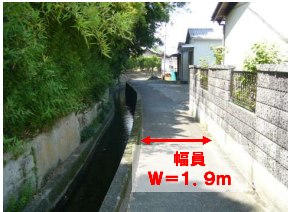
工事前の様子
