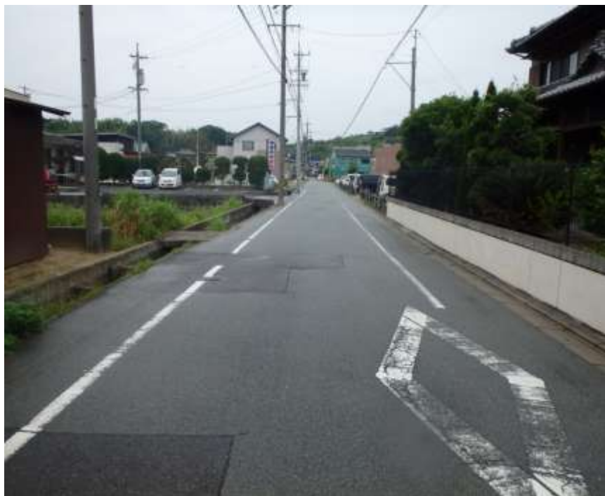
工事前の様子
