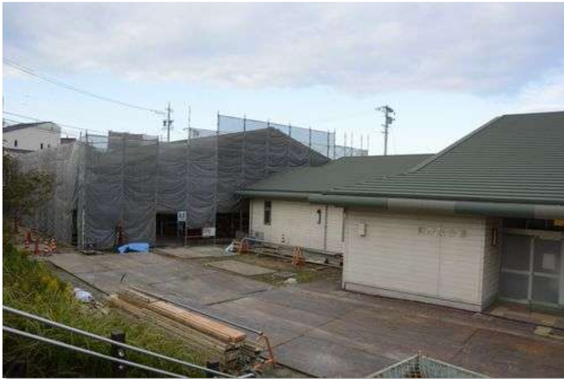
南が丘会館西隣に建設中 10月23日撮影
