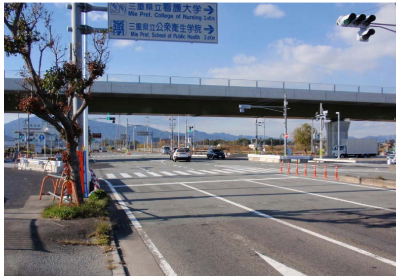
津(野田)工区 納所町交差点立体化【平成24年12月】
