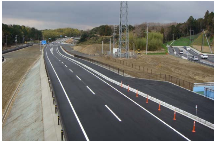
津(河芸)工区完成【平成24年3月】
