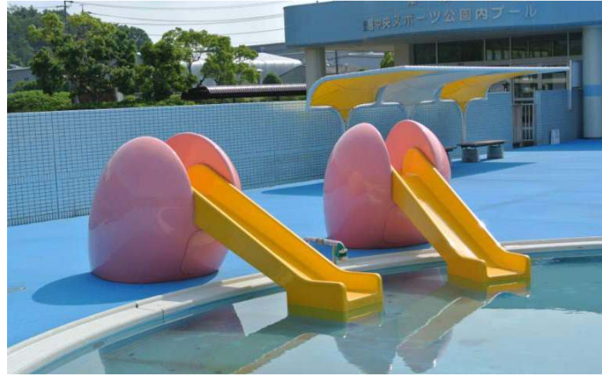
幼児プールに滑り台を設置
