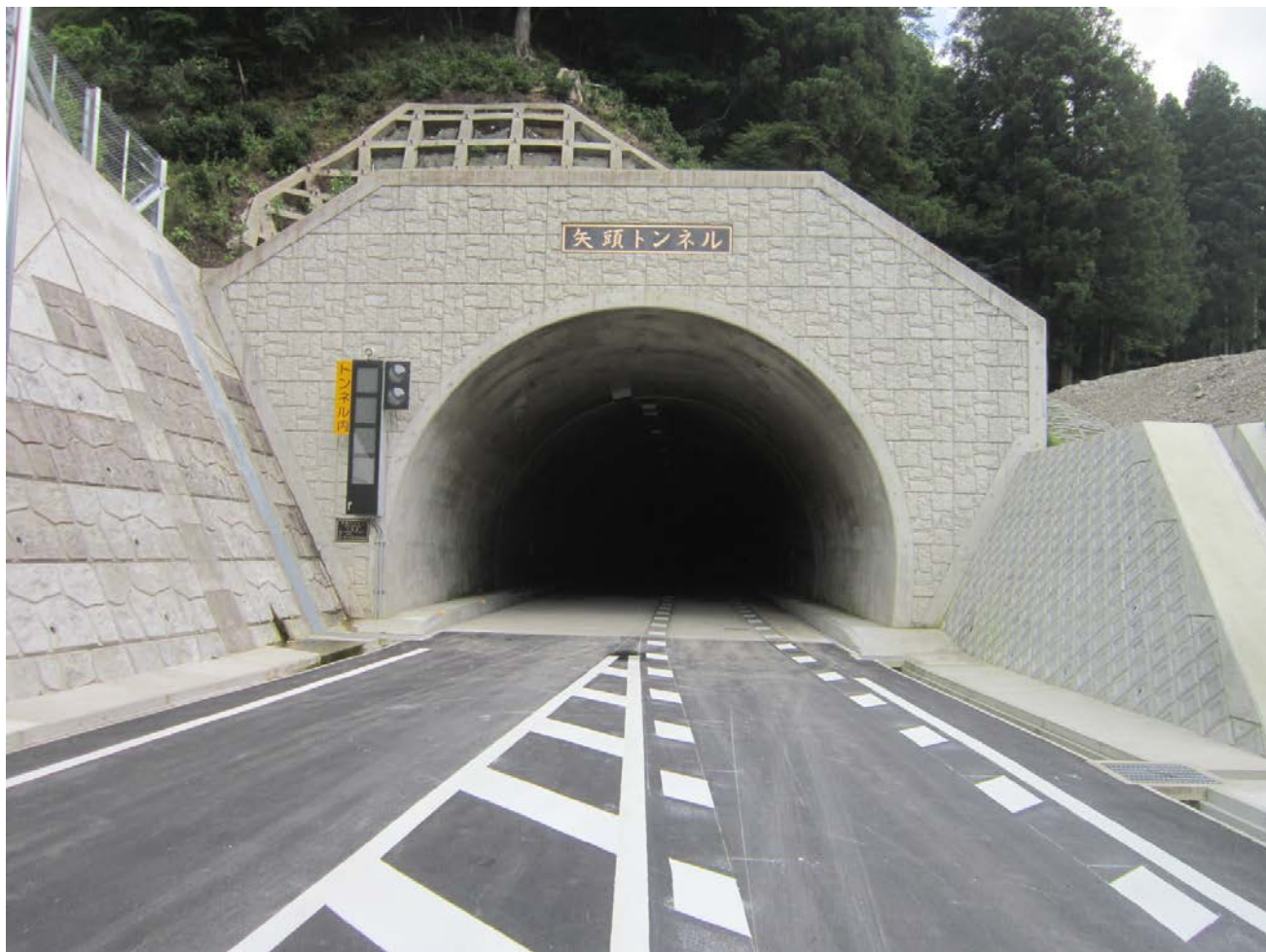
開通した矢頭トンネル(美杉側坑口)
