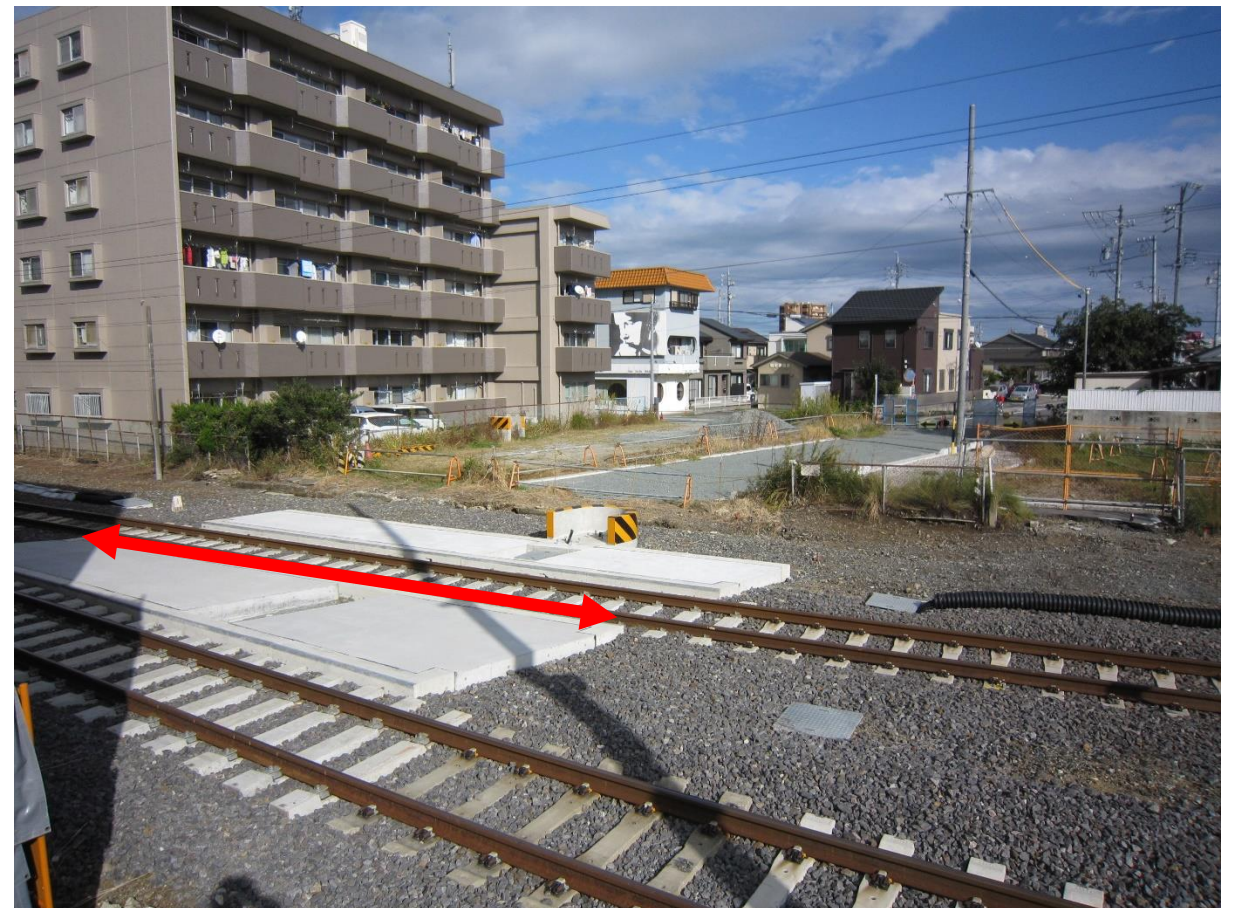
新踏切工事中
