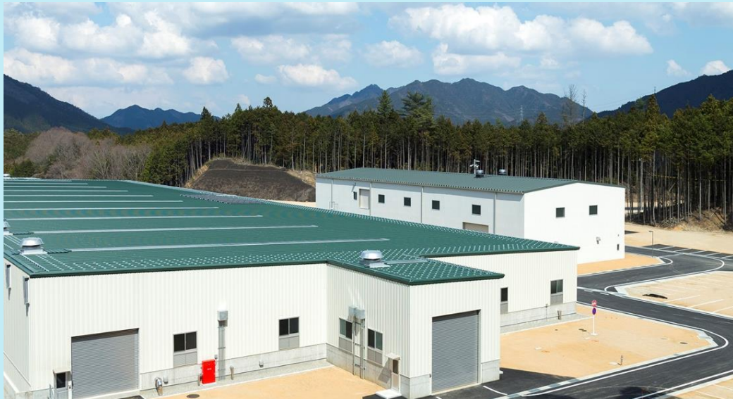
津市一般廃棄物最終処分場（美杉町下之川地内）
