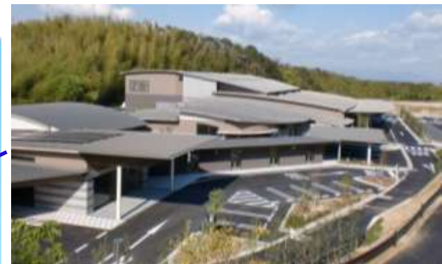
新斎場「いつくしみの杜」の整備 (平成27年1月2日供用開始)
