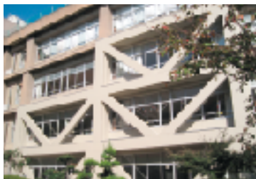
耐震改修の完了した校舎
