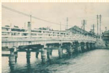
擬宝珠が取り付けられていた岩田橋
