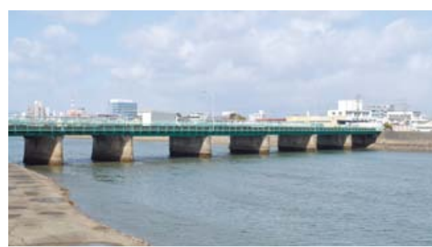
岩田川の下流側から見た現在の津興橋
