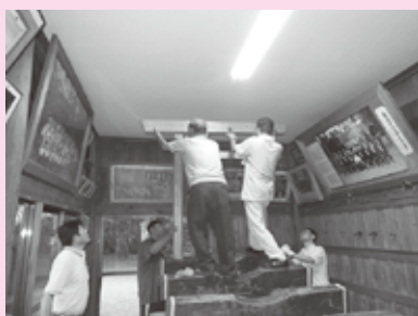
やぐら部分の取り付け
