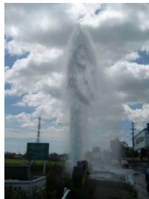
老朽化による管破損事故
