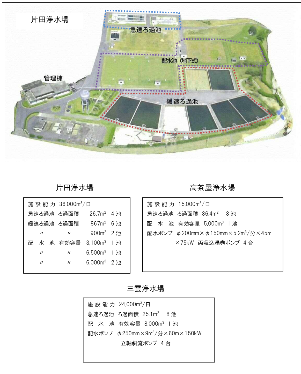
図 2.6 本市の主要な浄水場
