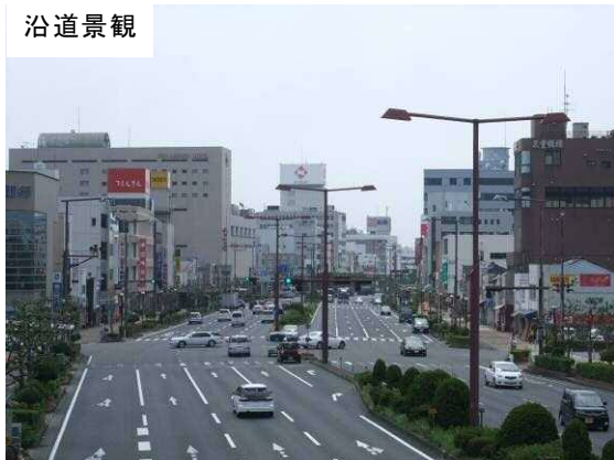
国道 23 号丸之内周辺（津地域）
