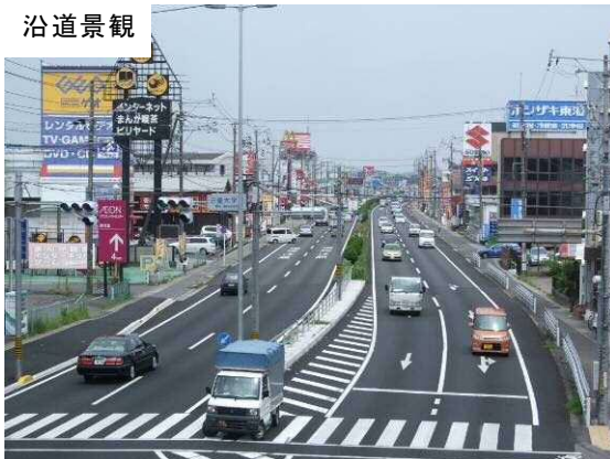
国道 23 号沿道三重大学周辺（津地域）
