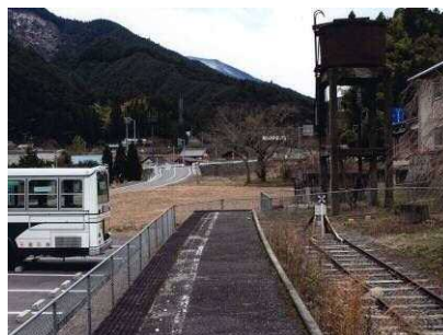
JR 名松線伊勢奥津駅と給水塔
