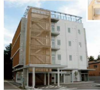
津市応急クリニック
