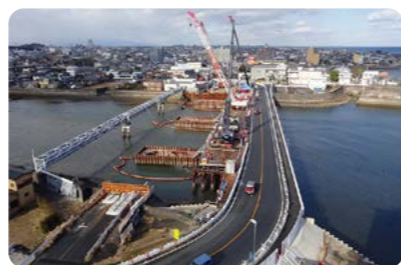
津興橋の架け替え工事
