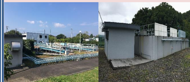
豊が丘団地汚水処理場
