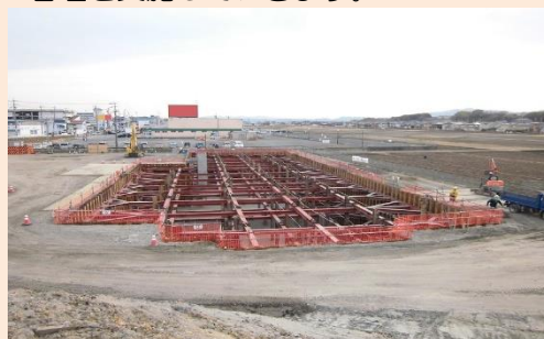
天神ポンプ場築造工事の様子
