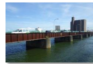
【架け替えを行う津興橋】
