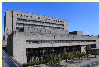
本庁舎設備等の大規模改修
