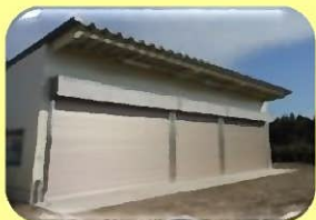
香良洲エコ・ステーション (平成29年度リニューアルオープン)
