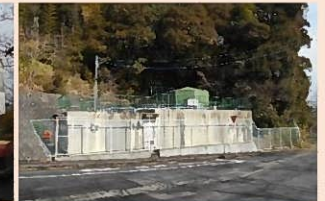
ピュアタウン汚水処理場
