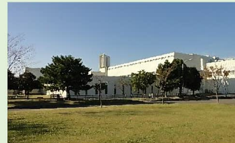
中央浄化センター
