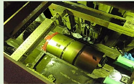
雨水管渠推進工事の様子
