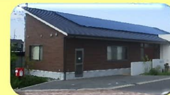
太陽光発電システム
