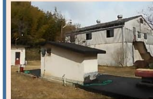
殿舟団地汚水処理場
