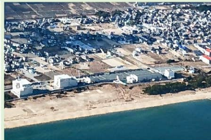
志登茂川浄化センター(平成30年度供用開始)
