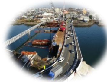
【架け替え中の津興橋】
