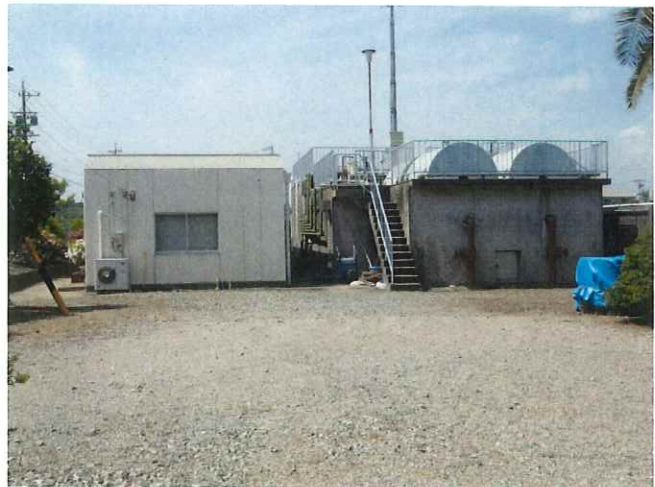
浸出水処理施設
