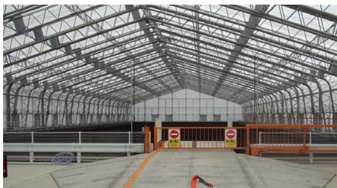
写真 3-3-2 平面トラス構造(例)
