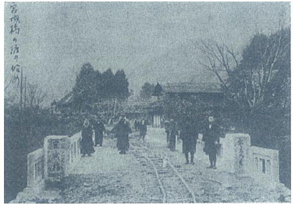
奥津宮城橋渡り始め（昭和 9 年）
