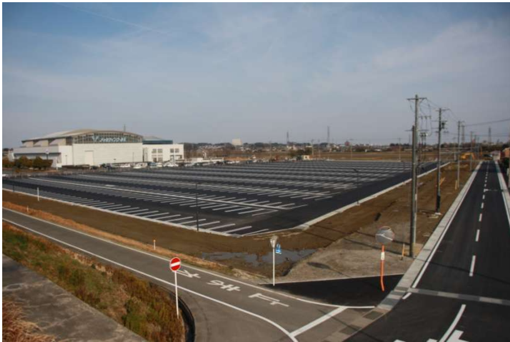
整備中の津市産業・スポーツセンター
