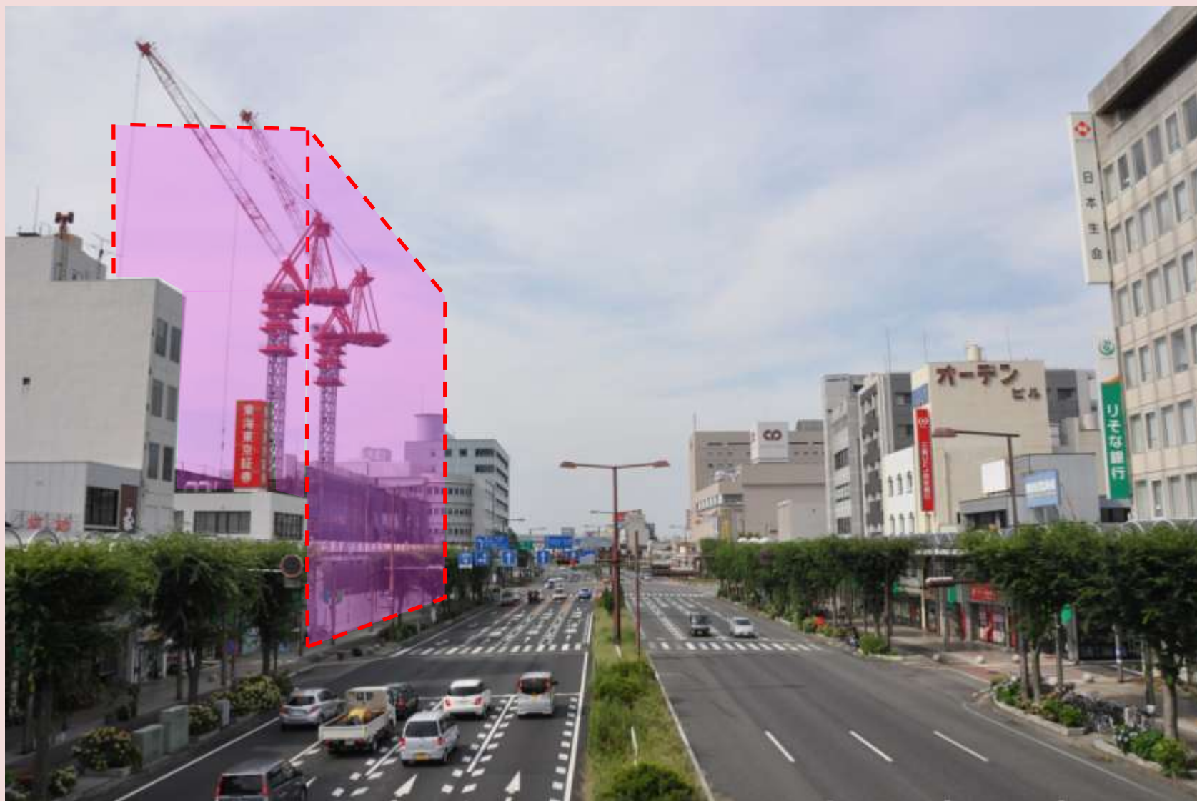
百五銀行本部棟(地上12階)建設中(H27.9完成予定)
