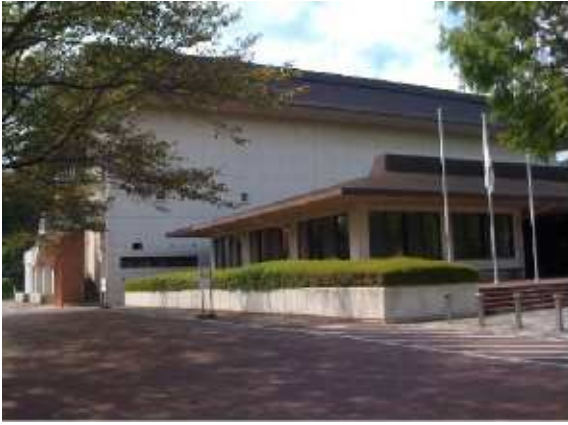
津市白山体育館 白山町古市808
