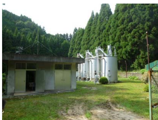
写真-11 青山高原簡易水道浄水場
