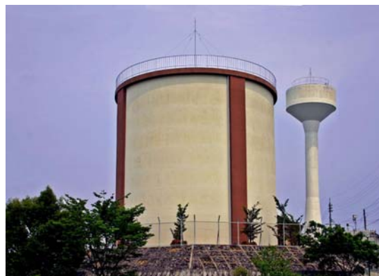
写真－9 南が丘配水池(左)、垂水山配水池(右)
