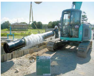
管網整備工事
