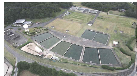
市内最大の片田浄水場 (制御機器など主に電気設備の更新)
