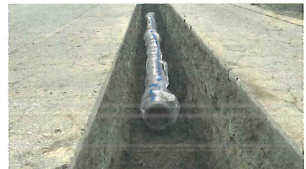
老朽管の更新工事
