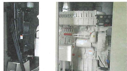
浄水場への非常用発電設備の設置
