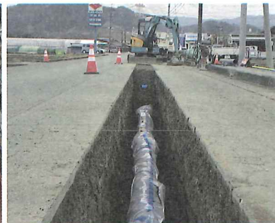
配水管布設工事の様子
