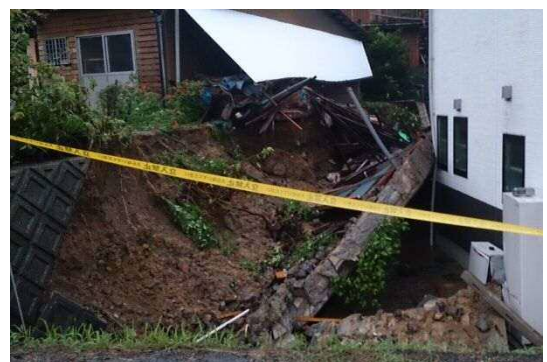
↑ 美里地域で発生した崩落現場
