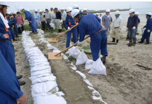
↑積み土のう工法を実施する消防団員
