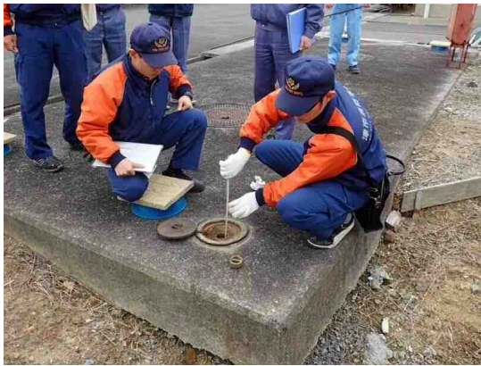
↑危険物地下タンクの検査を実施
