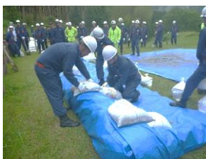
→積み土のう工法
