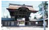
⑩ 高田本山専修寺唐門 真宗高田派本山の専修寺如来堂の正面に建つ門で天保15年(1844)上棟。屋根は檜皮葺で、正面と背面の軒に大きな唐破風があることから唐門と呼ばれる。
