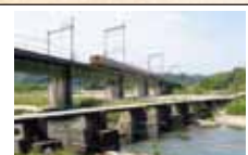
①雲出川の潜水橋 増水時は川の水位が橋の高さを超えるので沈下橋とも呼ばれる。幅員は狭く小型車両は通行できるものの、実際に渡る恐怖心に襲われる。
