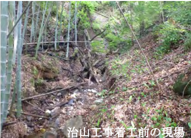
治山工事着工前の現場
