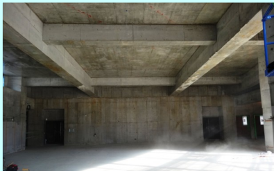
内部の様子(玄関ロビー、ホール入口)
