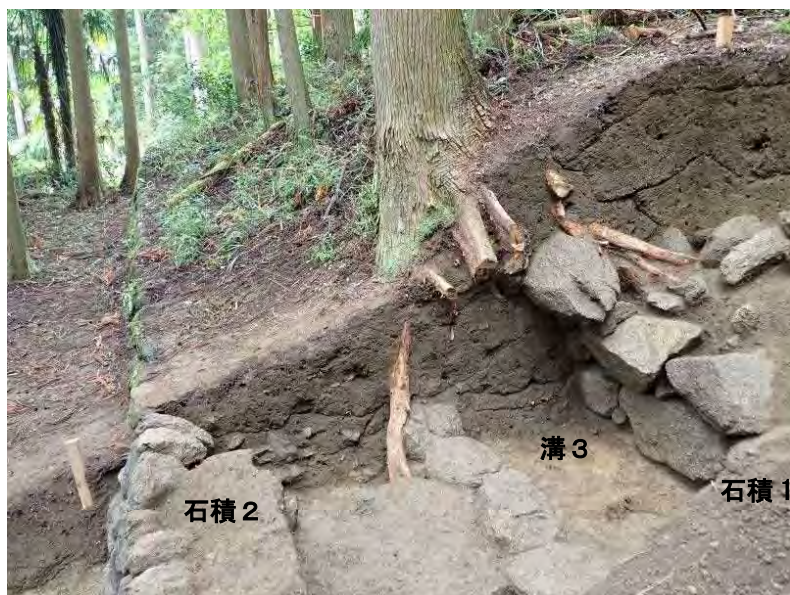
1T 石積1・2、溝3 東から
