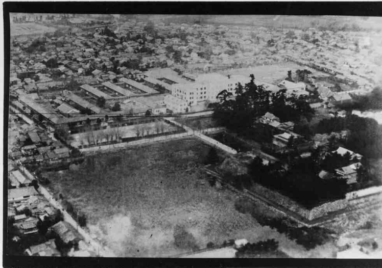
図 2-7 本丸南東側より。高山神社が本丸跡に建つ（昭和 11 年頃撮影）
