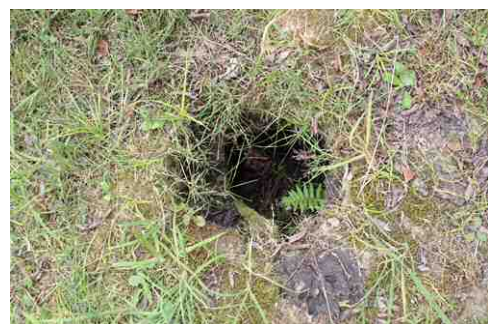
図 3-3 腐敗が進行した切株（北側石垣 P-n2）
