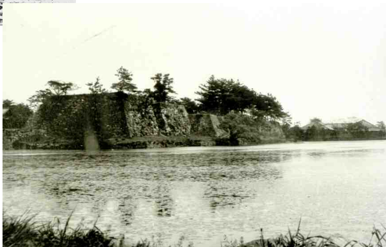
図 2-6 解体後の本丸南西側（明治・大正期撮影）
