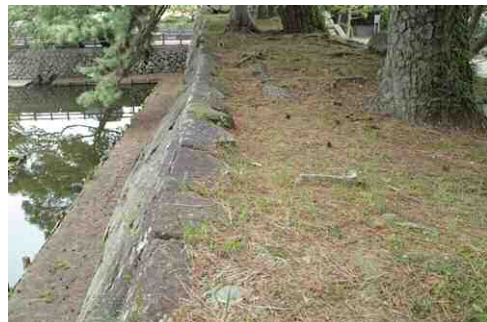
図3-1 天端面の高径木と孕み（Q-s 南側石垣）
