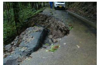
小杉地内で路肩が崩落した市道。
