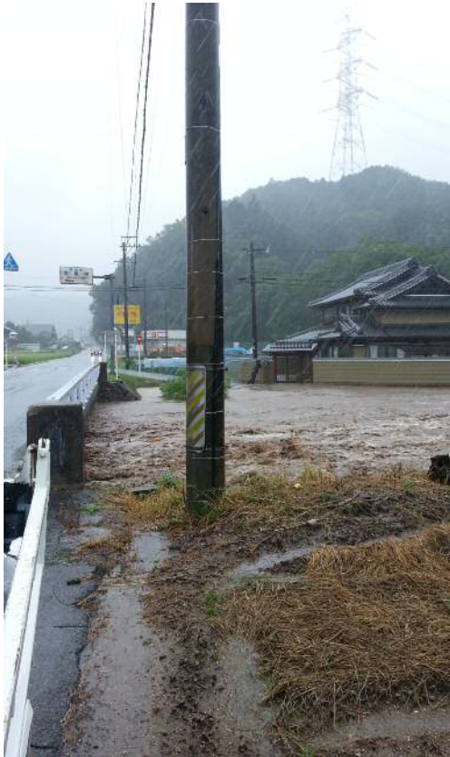
上ノ村地内国道165号の寺前橋下いっばいにまで増水した大村川。流域では多くの被害が発生しました。
