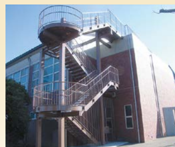
外部階段・屋上フェンスの設置(香海中学校)
