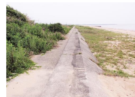
直轄事業延伸部分(長さ1,165m)
