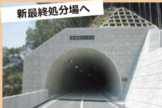
▶ 山口山本線「天狗松トンネル」
