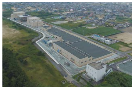
平成30年4月供用開始予定の志登茂川浄化センター
