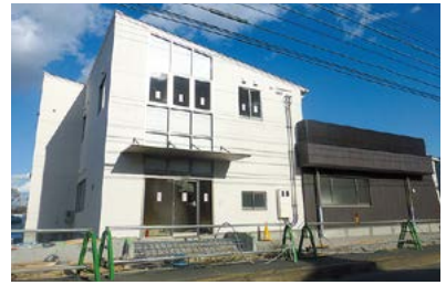
建築工事中の豊が丘おおぞら会館
