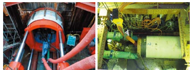
雨水幹線推進工事の様子
