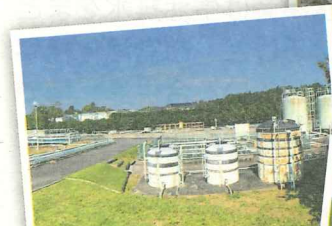
豊が丘団地の共同汚水処理施設
