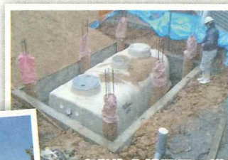
市営浄化槽設置の様子
