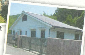
大里地区の農業集落排水処理施設
