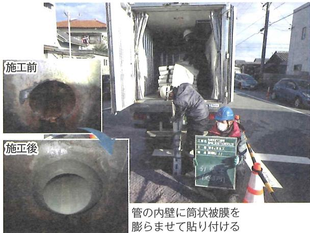
老朽化した污水管の修理や耐震化をする時は、内側を特殊な加工で改築する管更生工法を採用しています。道路を掘り返さず工事ができるため、安価で短期間の施工が可能です。
