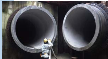
半田川田雨水幹線築造工事の様子
