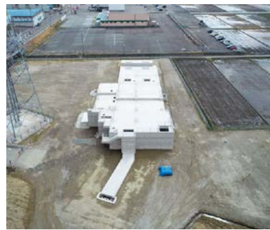
整備中の天神ポンプ場(3月18日)
